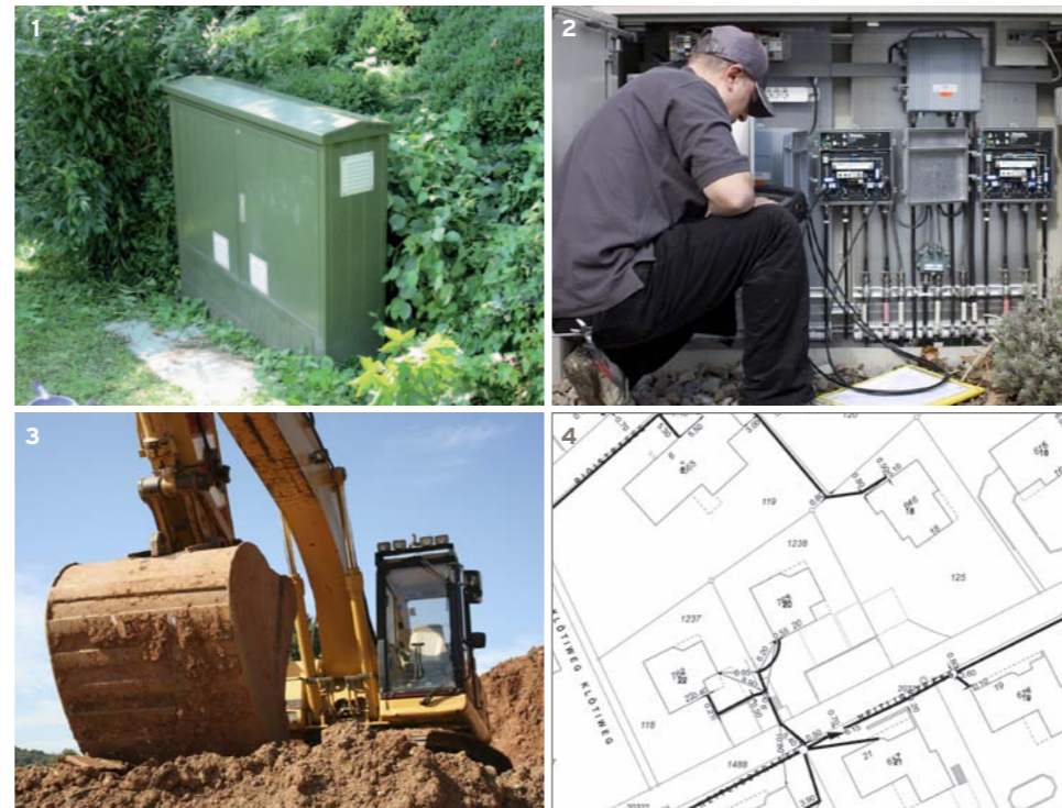
1 Verteilerkasten zur Kabelfernseh-Versorgung der umliegenden Häuser / 2 Innenansicht des Verteilerkastens mit Anschlussleitungen für Häuser in der Umgebung / 3 Gut vorbereitete Grabungsarbeiten sind effizienter / 4 Leitungskatasterplan mit Kabelverlauf gratis bei uns erhältlich
