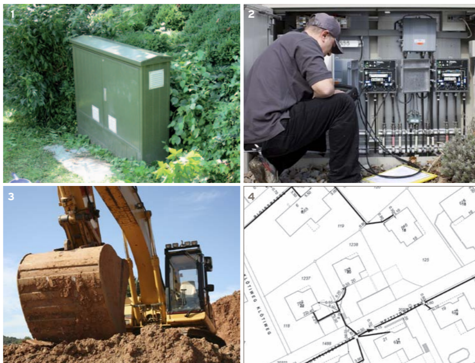
1 Boîte de distribution pour le raccordement à la TV câblée des maisons environnantes / 2 Vue de l'intérieur d'une boîte de distribution avec les lignes de raccordement des maisons avoisinantes / 3 Les travaux de fouille sont plus efficaces lorsqu'ils sont bien préparés / 4 Plan cadastral des lignes, disponible gratuitement auprès de nos services
